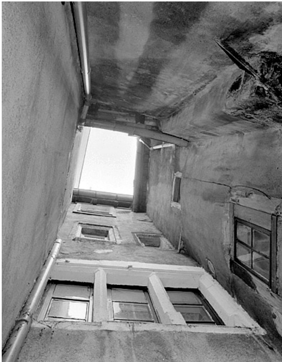
Cour. En bas, façade du premier corps de bâtiment. A droite, tour d'escalier. En haut, deuxième corps de bâtiment.
