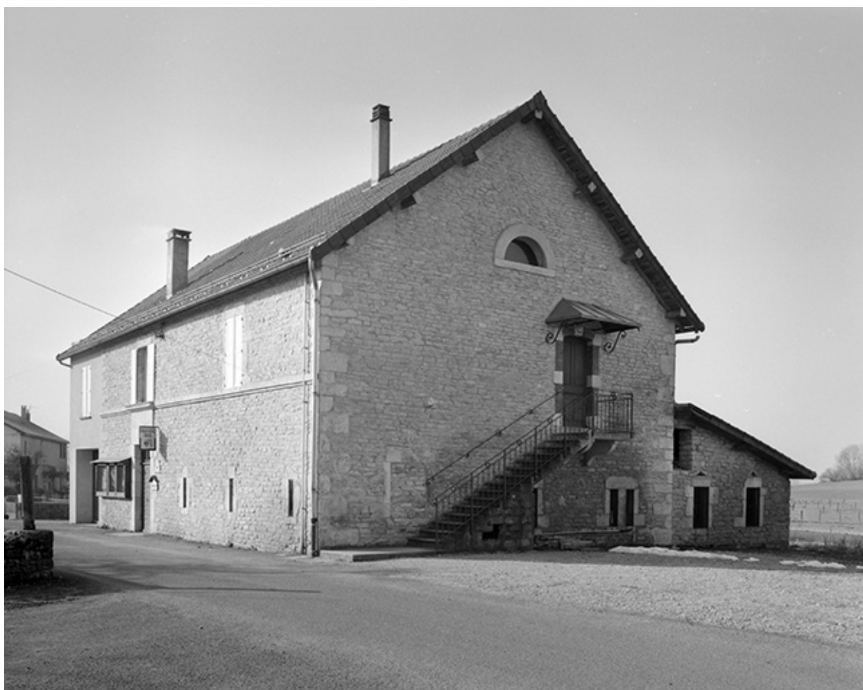
Vue depuis le nord.
