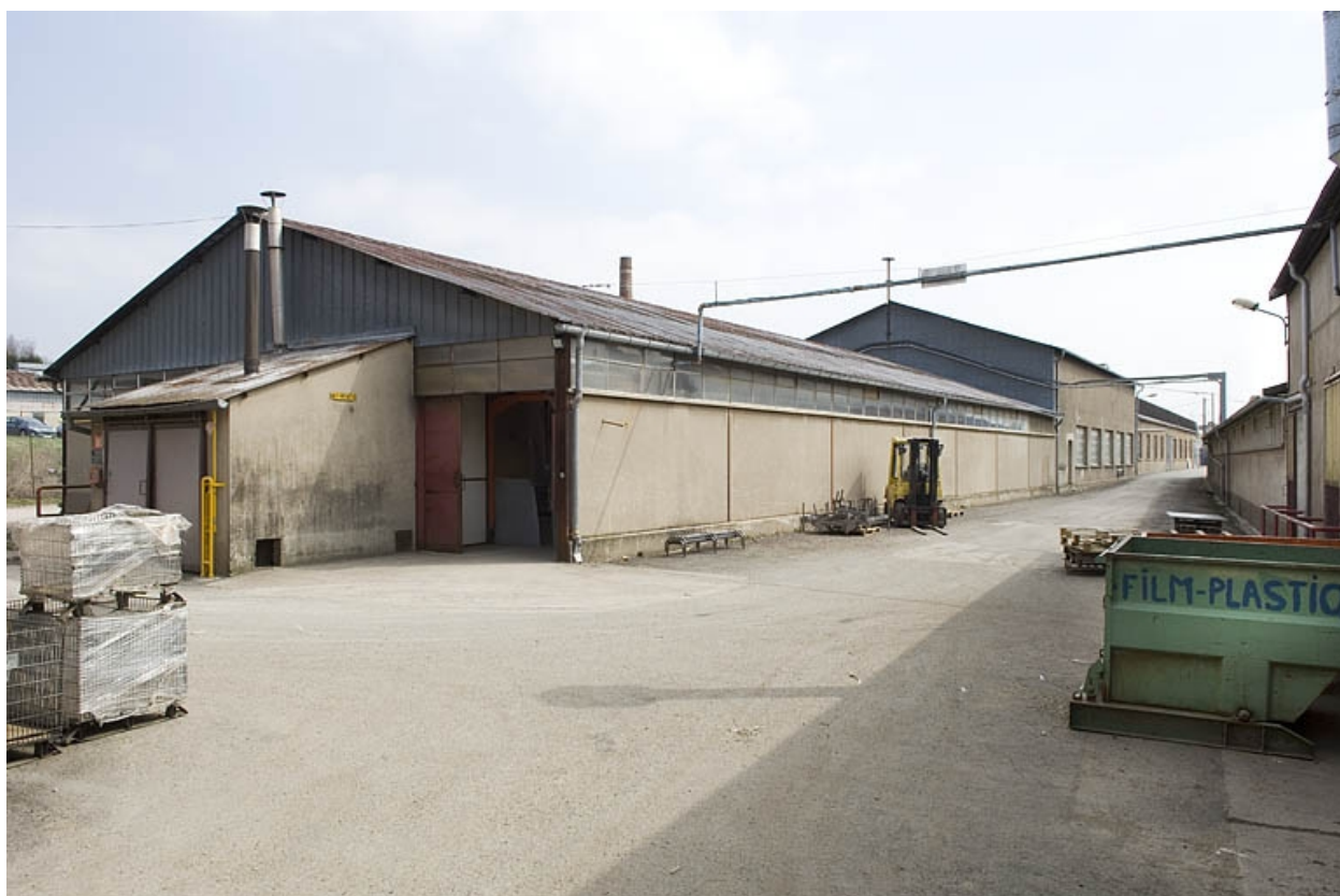
Façades d'ateliers depuis la cour.
