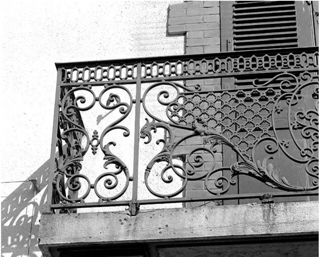
Détail de la grille d'un balcon des bureaux.
