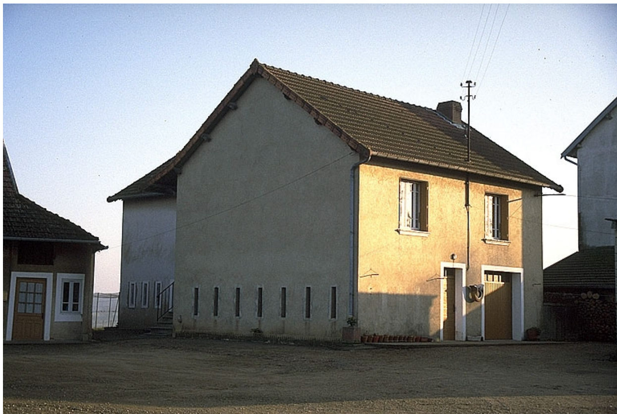
Fromagerie vue du nord.
