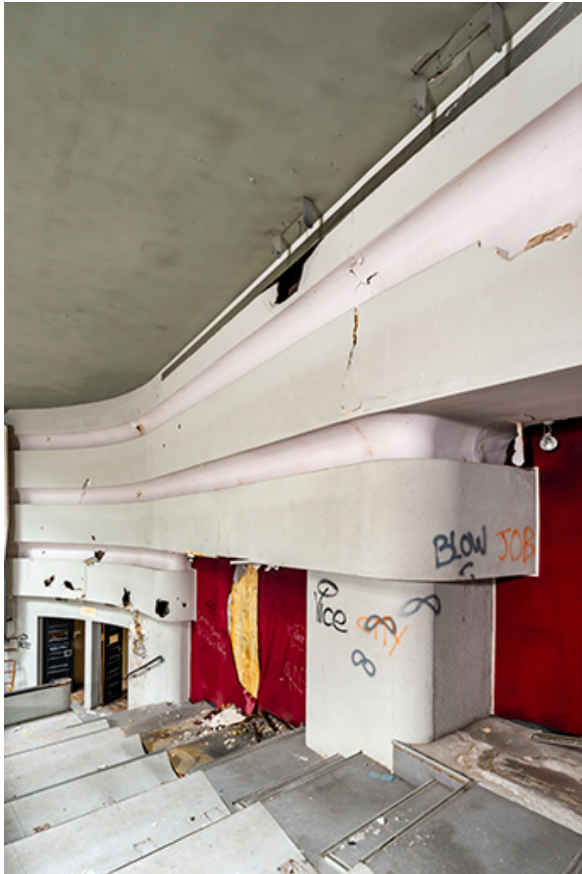
Halle : grande salle, paroi latérale droite et corniches (cadrage vertical).
