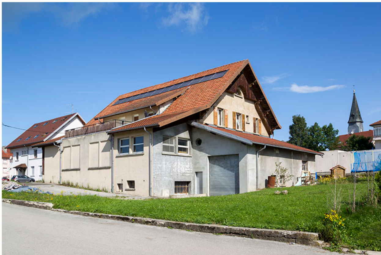
Façades postérieure et latérale droite.
