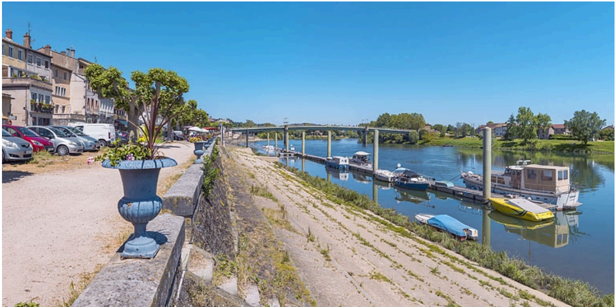
Vue d'ensemble des quais à gradins.
