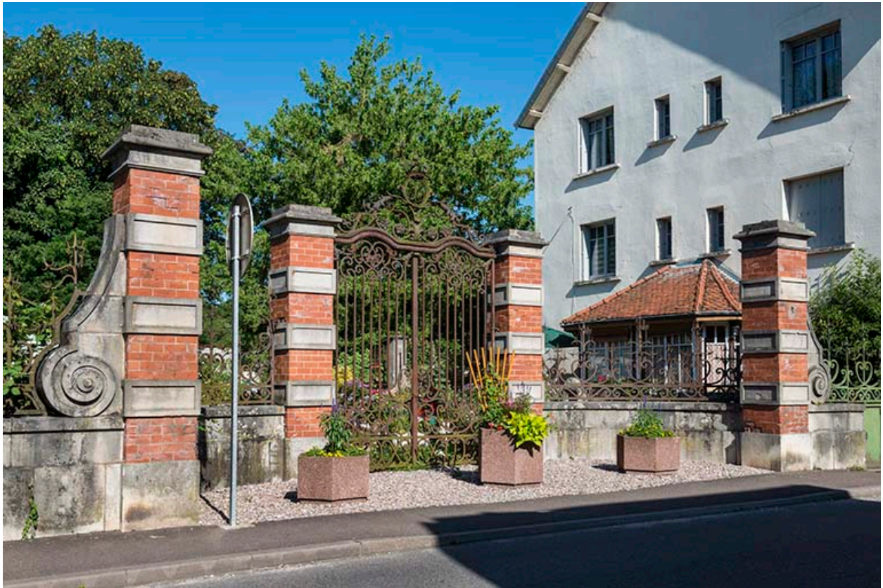
Clôture (grille) sur la rue Armand Paulmard.
