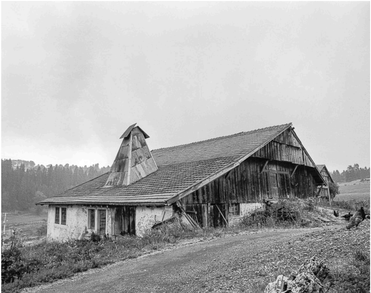
Ferme située au lieu-dit Remonot, cadastrée AC 50 : façade postérieure.
