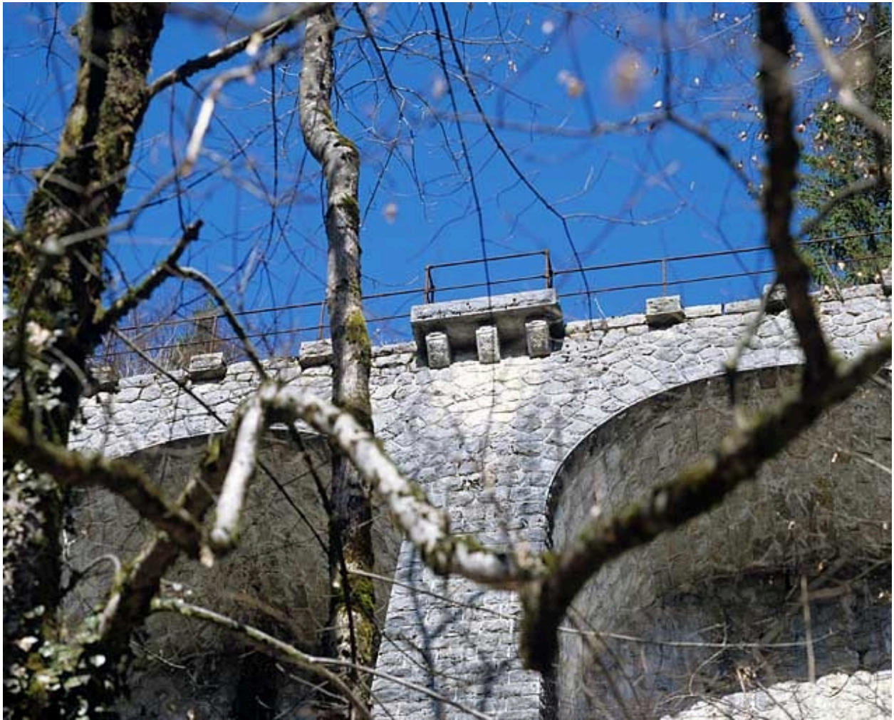
Pile centrale et refuge, vus en contre-plongée.
