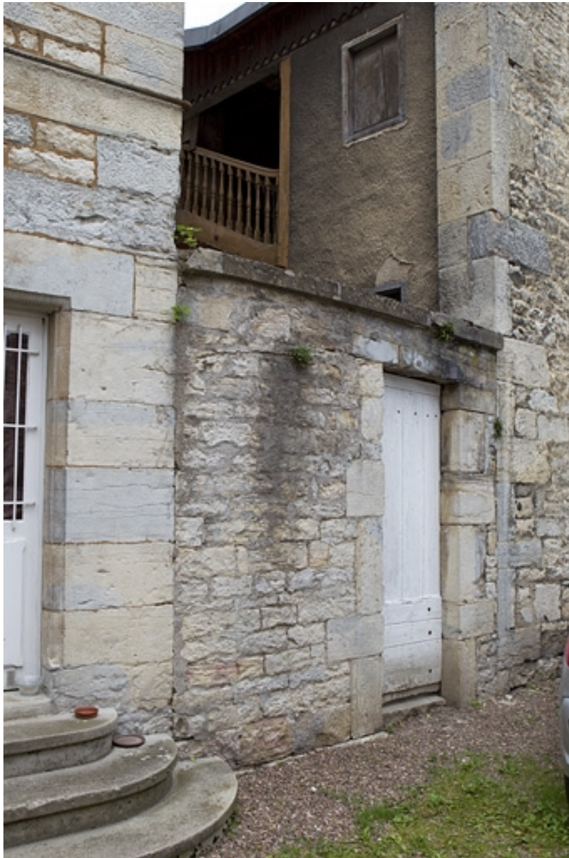
Détail du mur de clôture de la cour depuis celle de l'hôtel Alviset.
