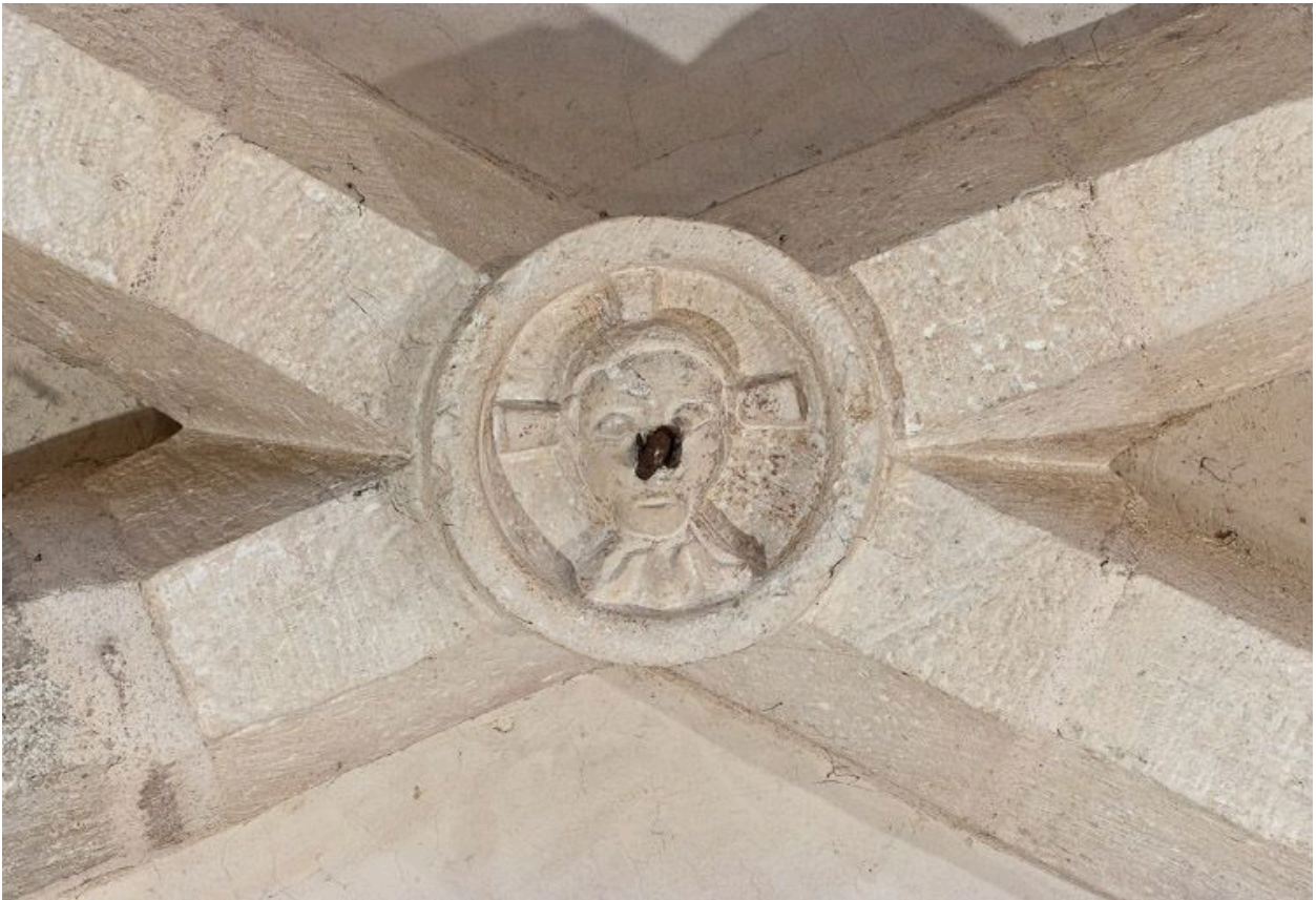
Clef de voûte de la troisième travée du bas-côté gauche.
