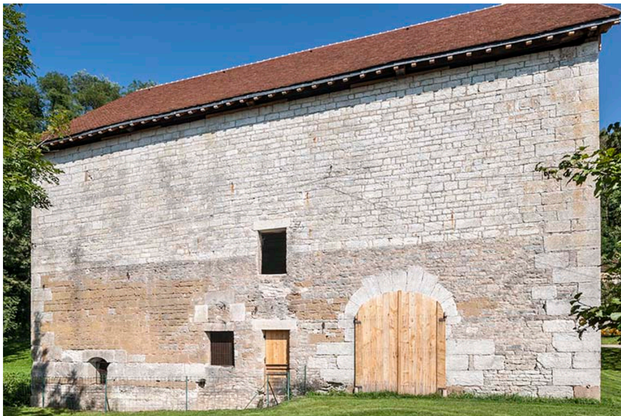
Façade sud du bâtiment du haut fourneau.
