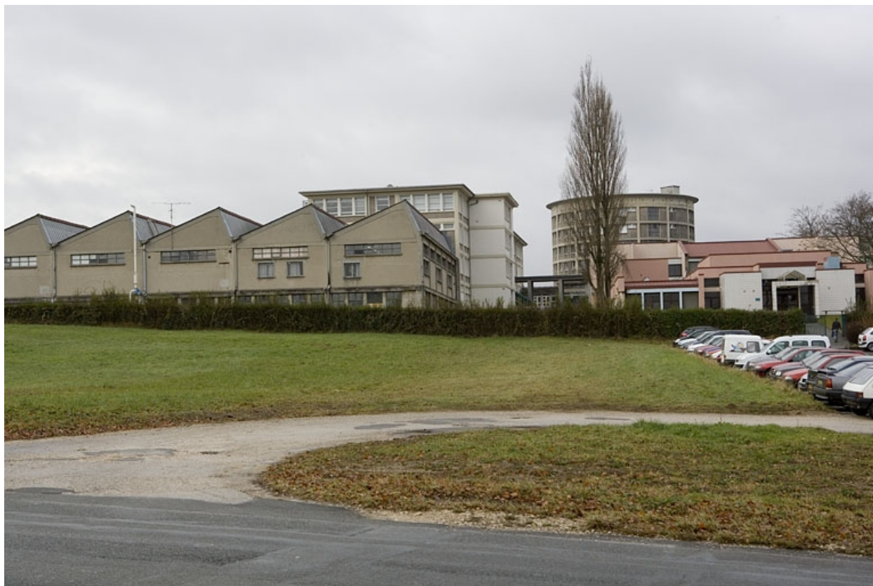
Vue d'ensemble. Façade postérieure du bâtiment B.
