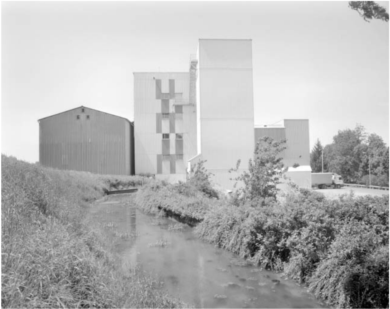
Silo et atelier de fabrication depuis l'est.
