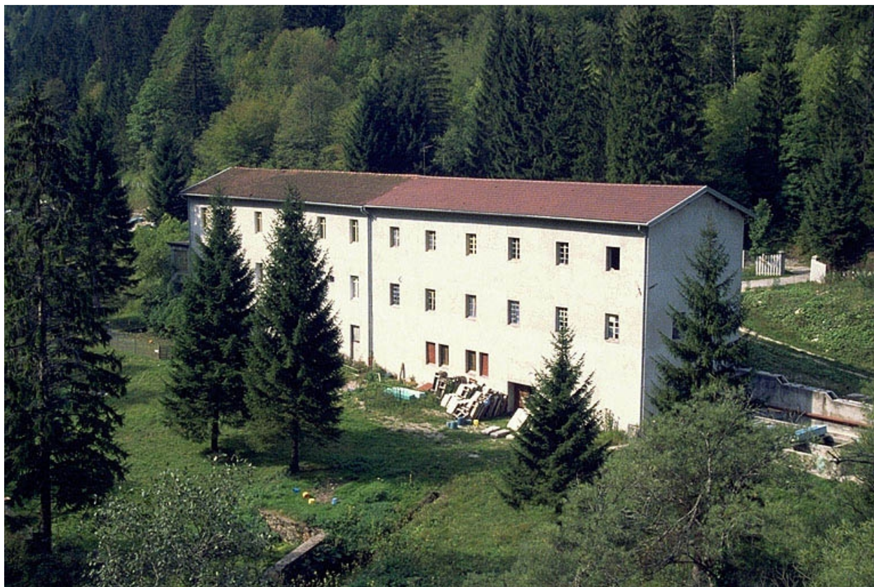
Vue d'ensemble depuis l'est (façade postérieure).
