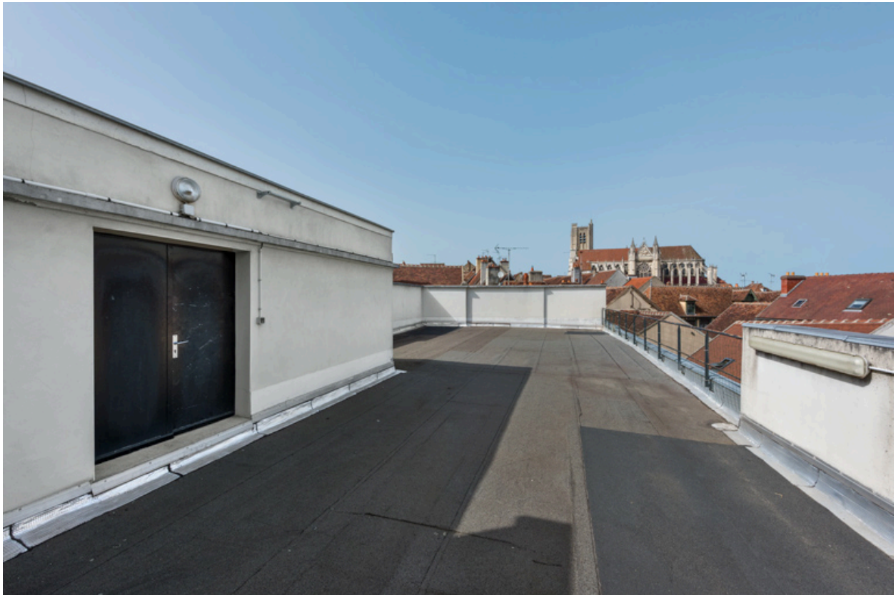
Terrasse sur l'aile sud (ancienne terrasse de récréation des filles).
