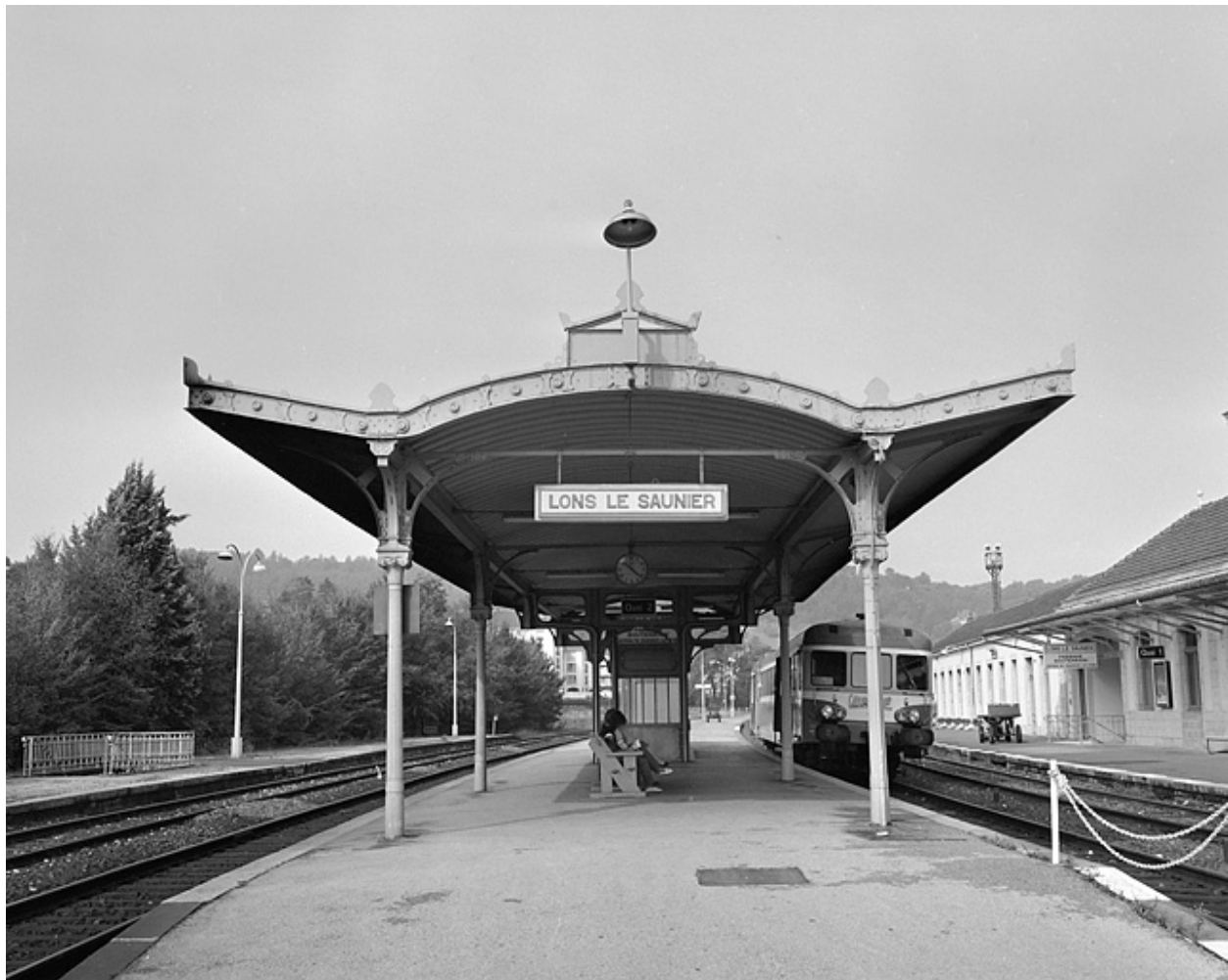
Abri métallique sur le quai.
