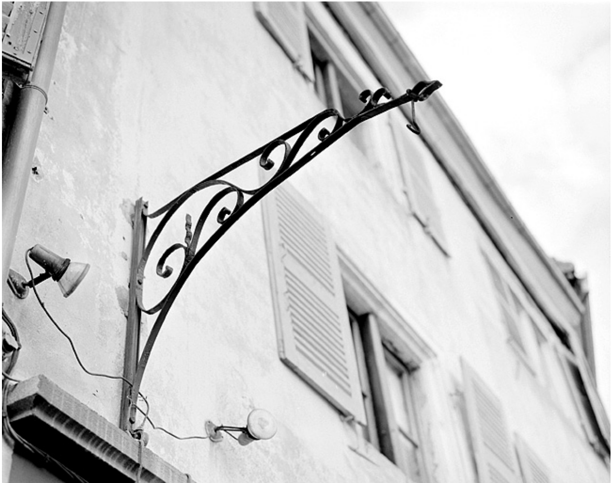
Façade principale, support d'enseigne (19e siècle).
