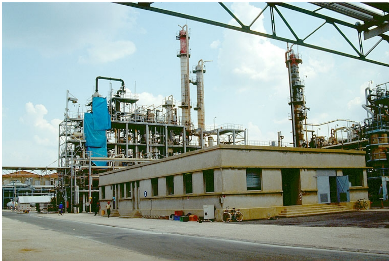
Salle de contrôle (34) du TRI71.
