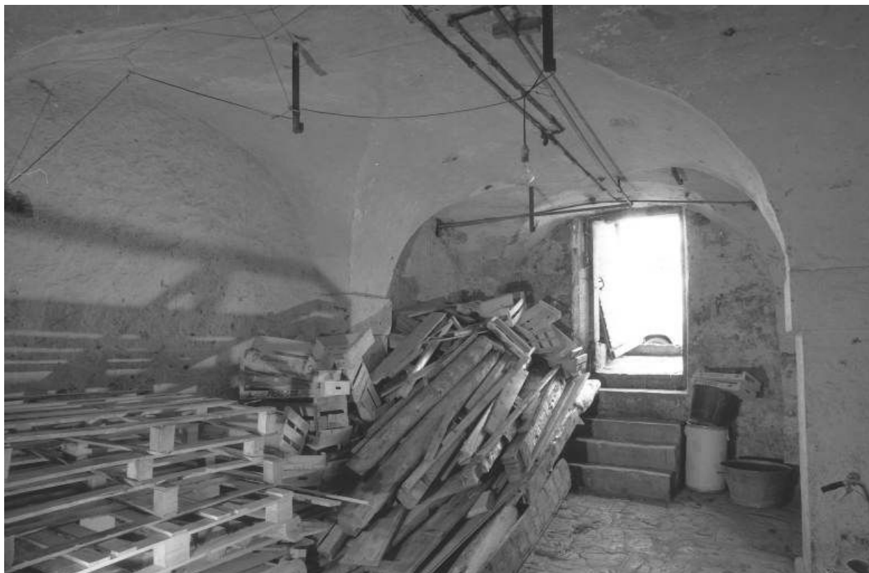
Pièce voûtée, en sous-sol.
