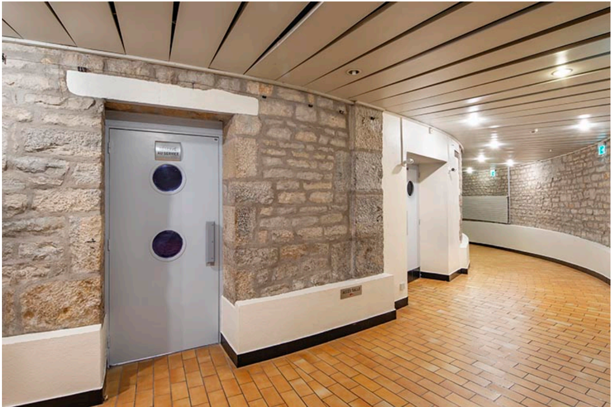
Petit Kursaal : couloir côté cour, avec entrée de la régie à gauche, de la salle à droite.
