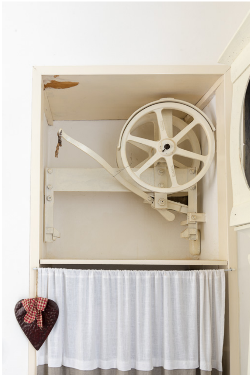
Mécanisme de monte-charge.
