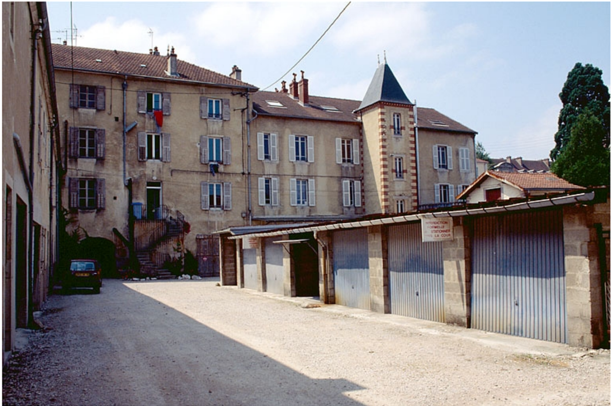
Logement patronal depuis le nord-est.
