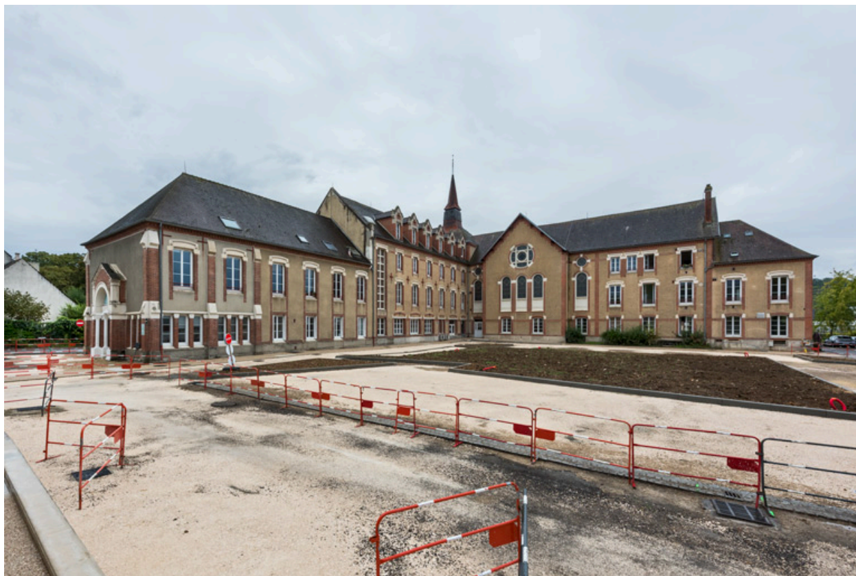
Vue d'ensemble du séminaire : façades nord et est.
