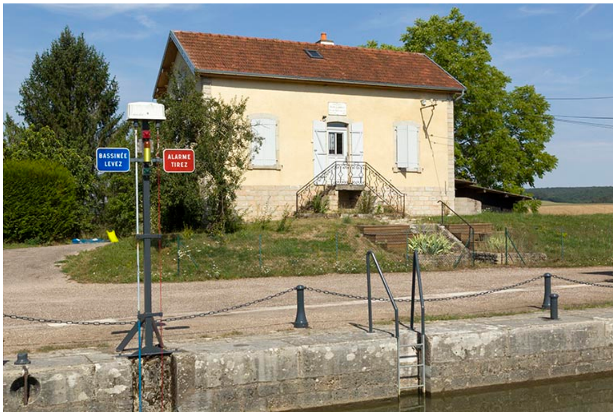
Vue de face de la maison d'éclusier.
