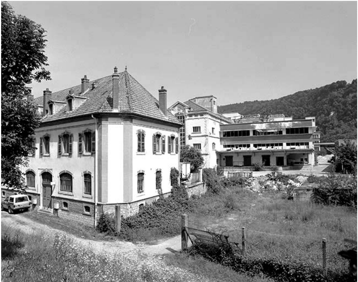
Extrémité occidentale des bureaux et cantine.
