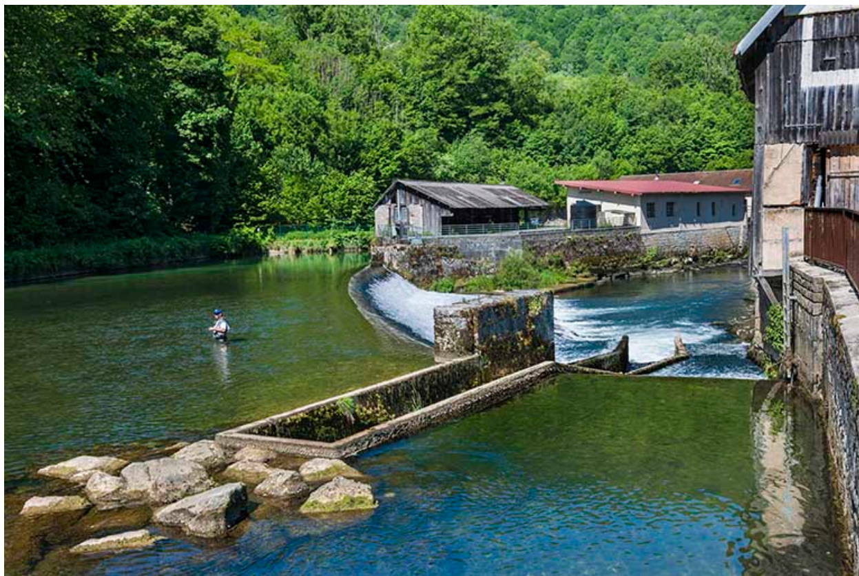
Le barrage de l'usine du Moulin-Neuf.
