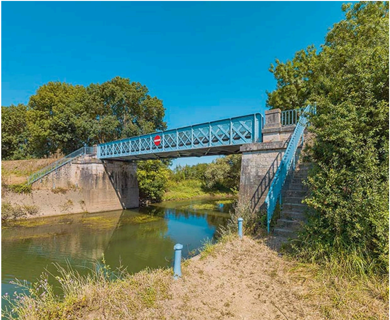
Le pont sur la Dheune, vu d'amont.
