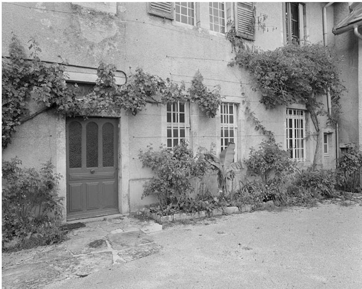
Façade antérieure, partie droite.
