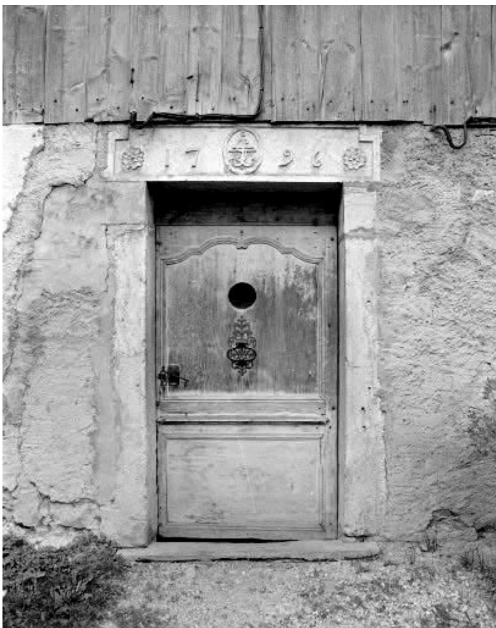
Façade antérieure : porte d'entrée.
