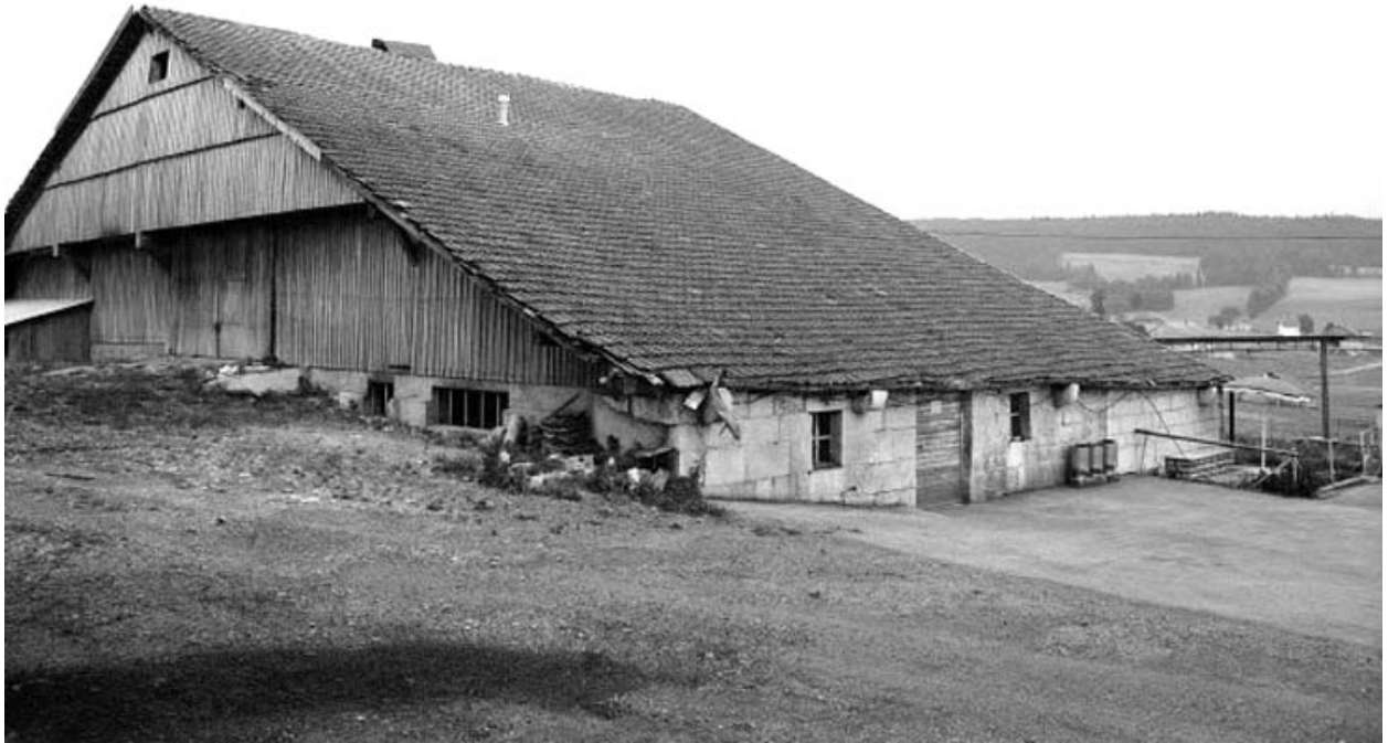
Facades postérieure et latérale gauche.
