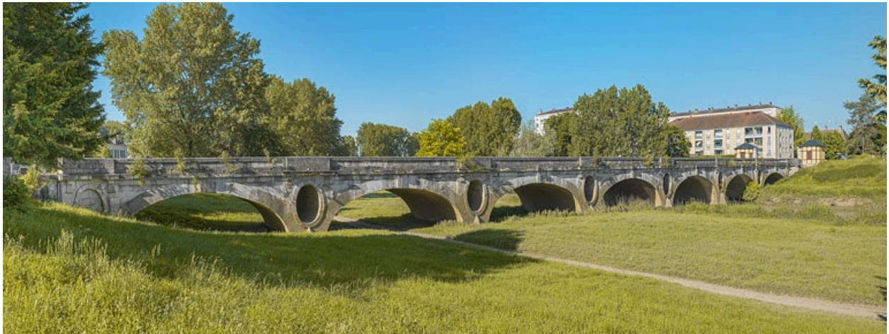
Vue d'ensemble du pont des Chavannes.
