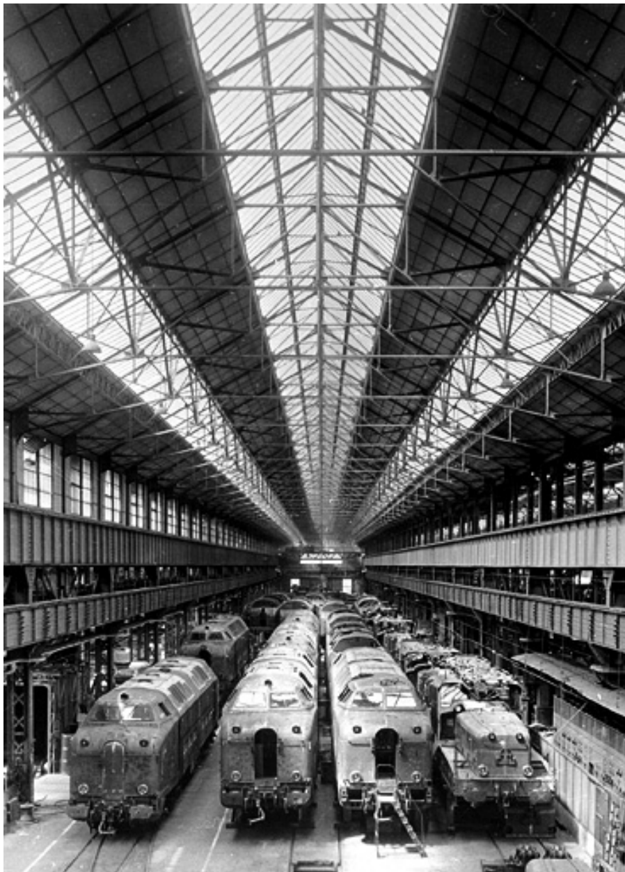
Hall de montage des locomotives diesel-électriques.
