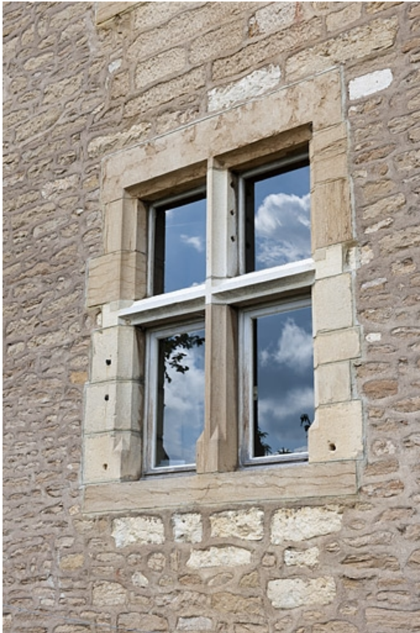
Demeure de Philibert de Molans (F), façade postérieure, détail d'une baie.
