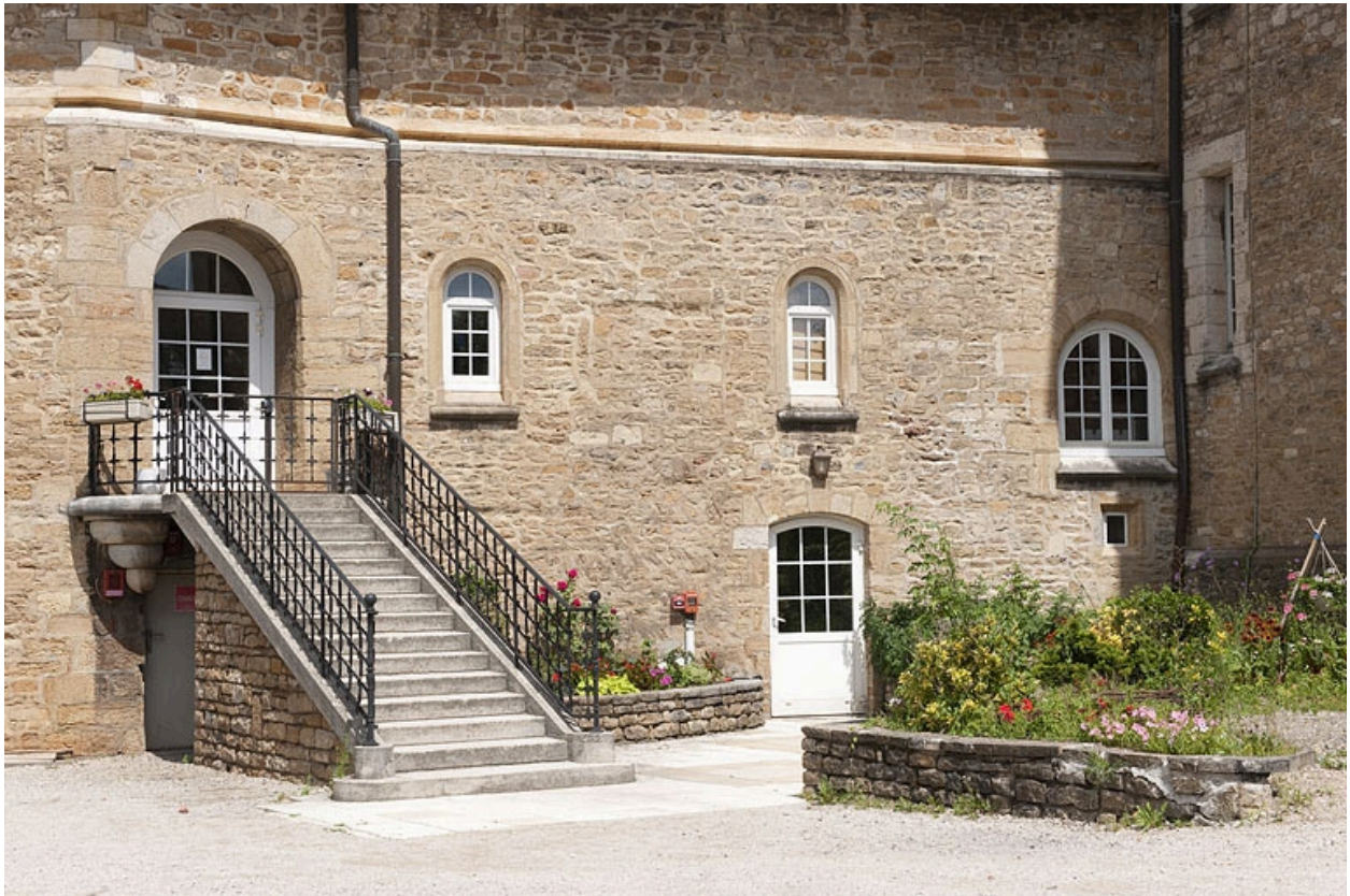
Bâtiment (C), escalier côté cour.
