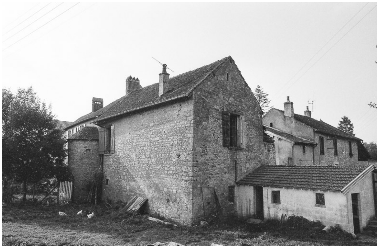
Façade latérale droite.
