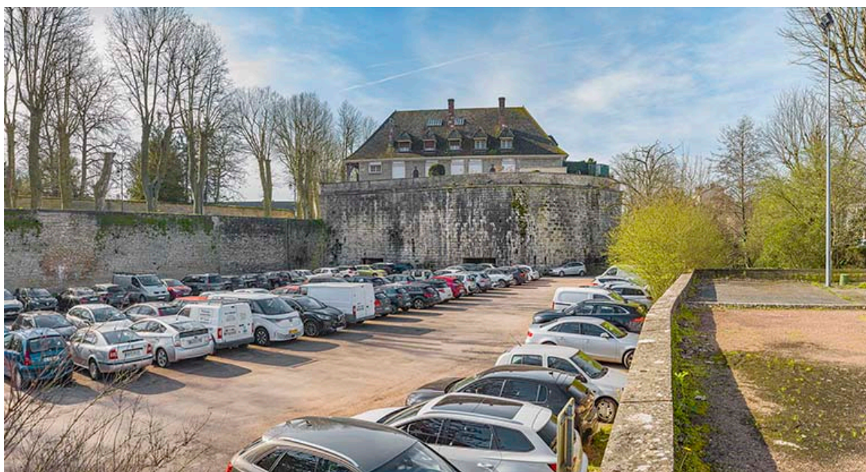
La tour depuis l'ancien fossé.
