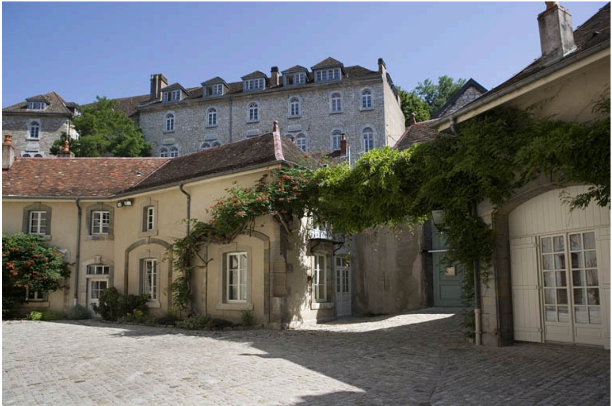
Détail des communs, partie gauche de trois quart droit.
