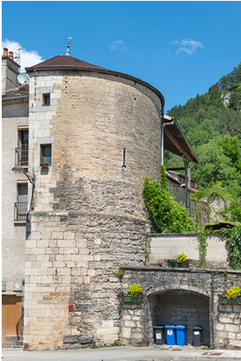
Vue rapprochée depuis l'ouest.
