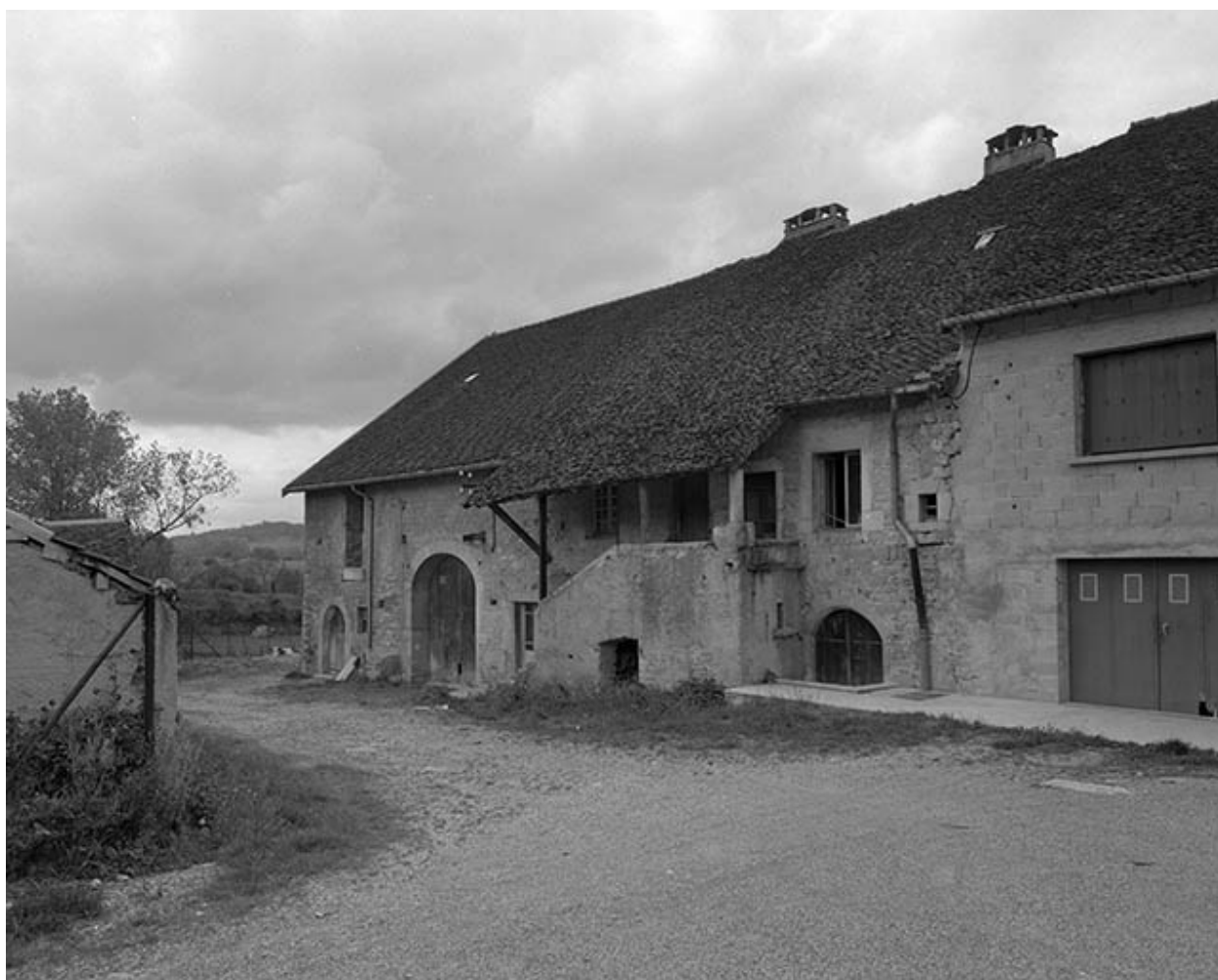
Ferme située rue du Tour : façade antérieure.
