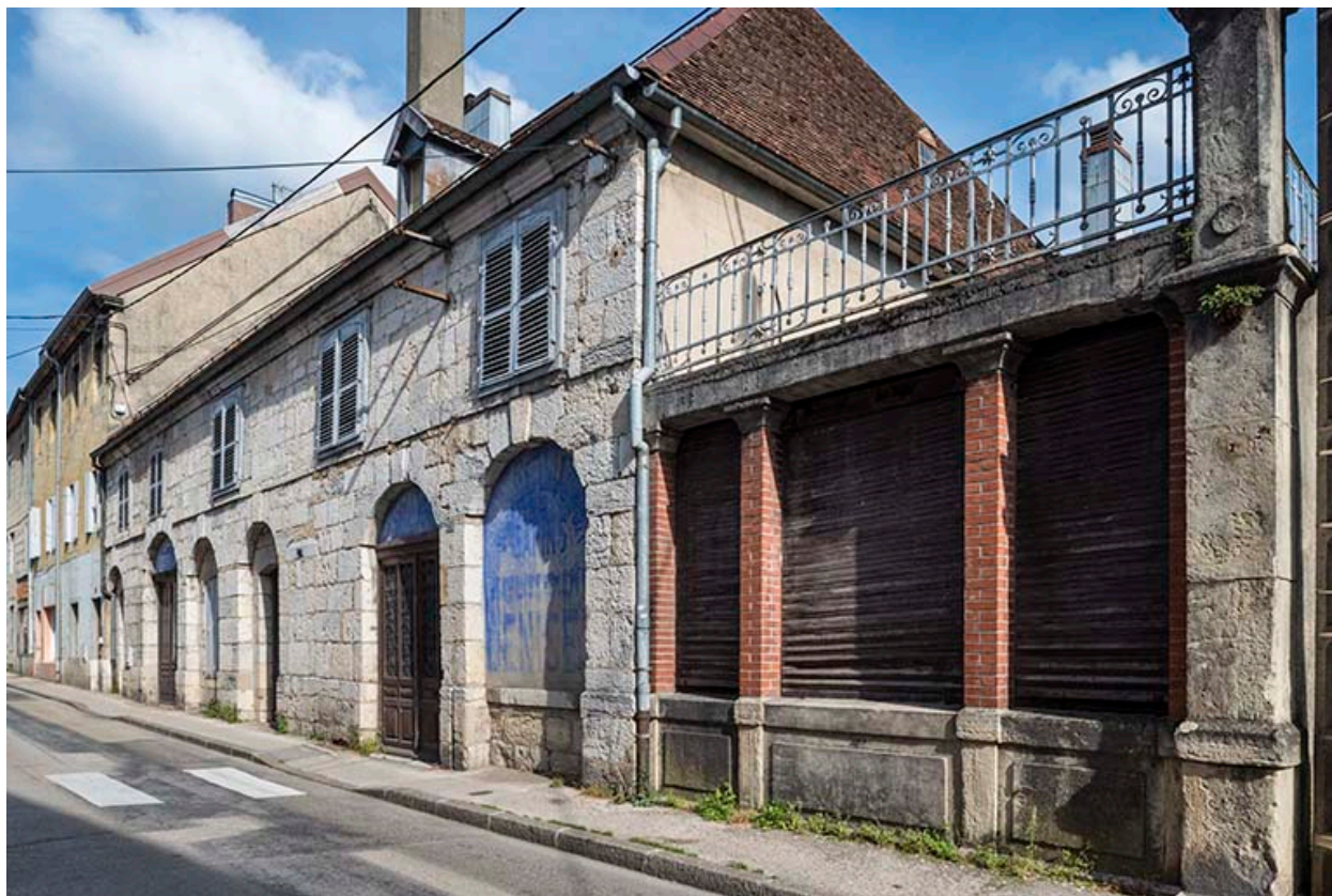
Vue rapprochée depuis le sud-ouest.
