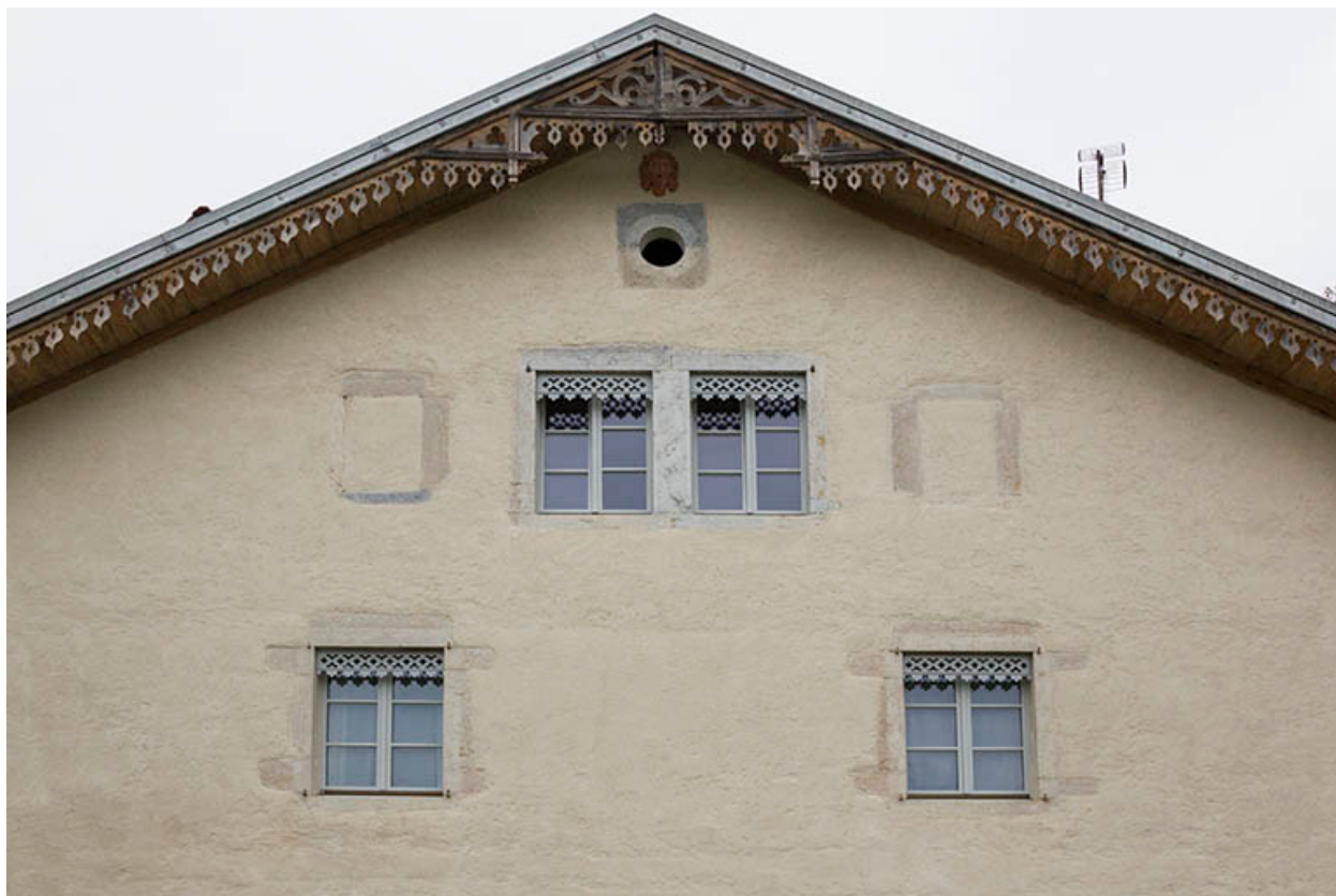
Façade antérieure : fenêtres horlogères du 1er étage de comble.
