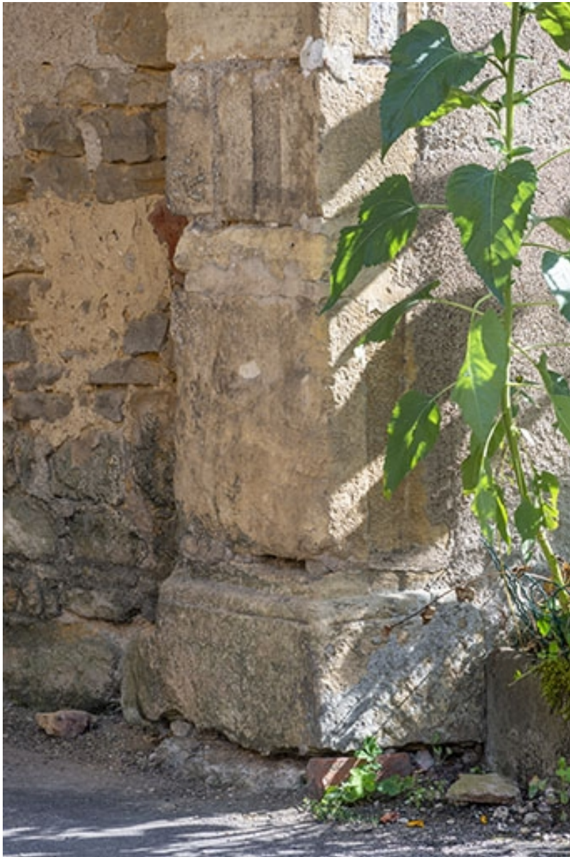
La base du piédroit du portail.
