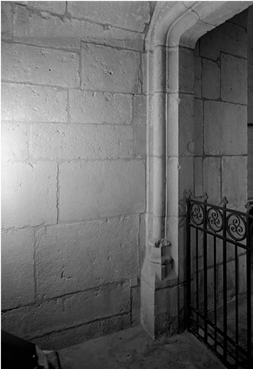
Détail du piédroit gauche de l'ancien portail de la première travée sud (actuellement chapelle des fonts baptismaux).
