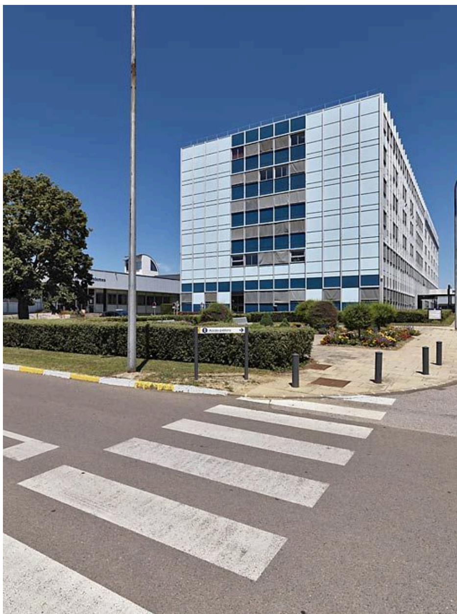
Bâtiment principal, vue d'ensemble de trois-quarts.
