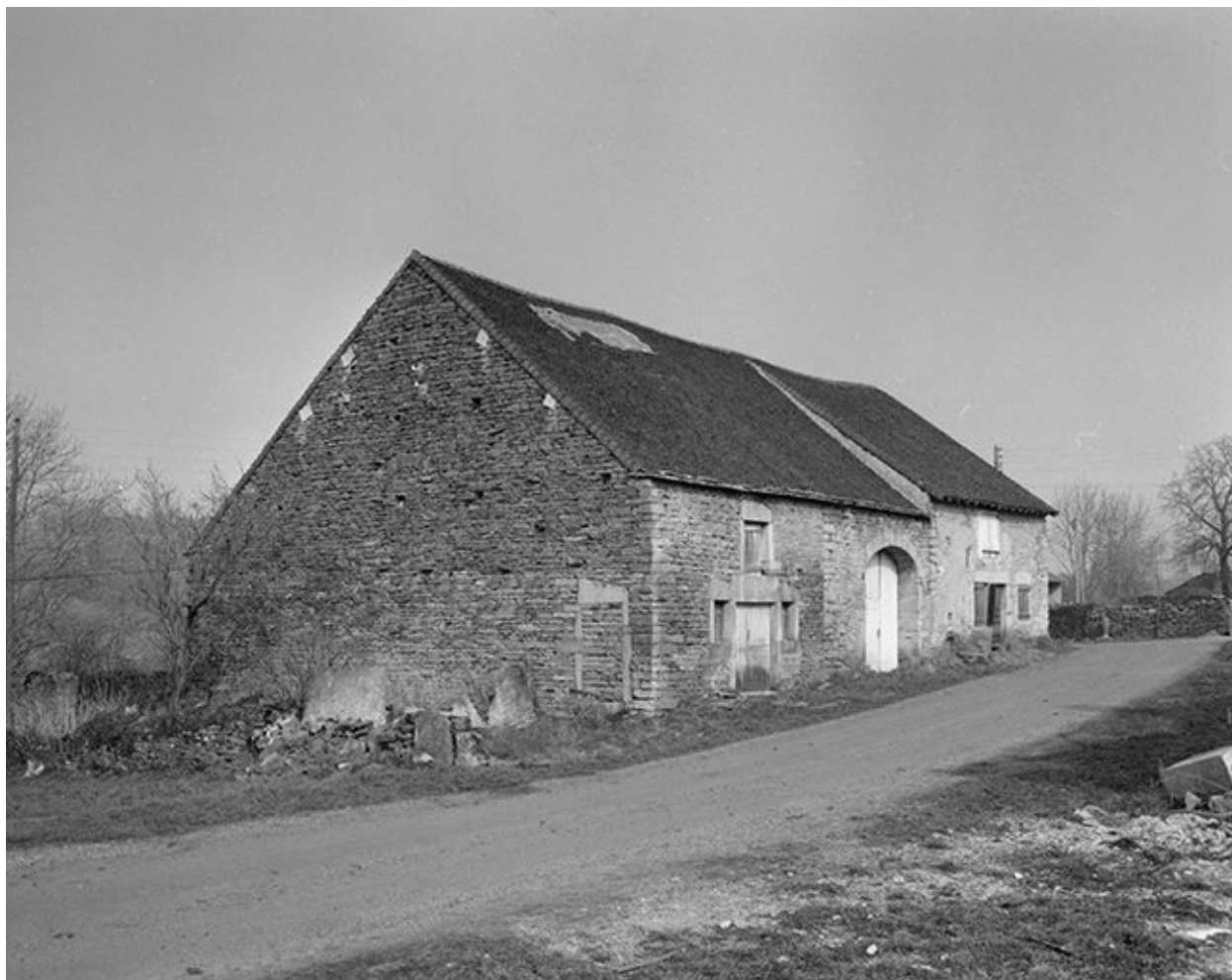
Façade antérieure et pignon gauche.
