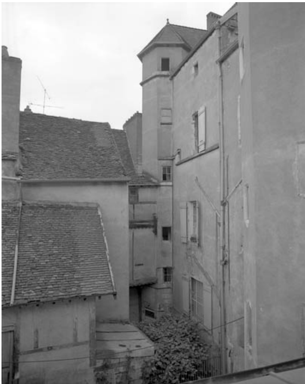
Façade postérieure depuis l'arrière-cour du 99 Grande rue.
