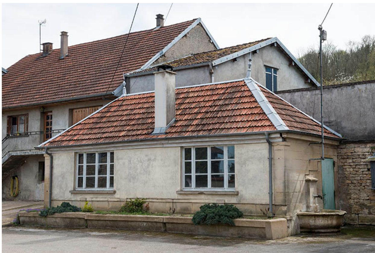
Ancien lavoir transformé en remise.
